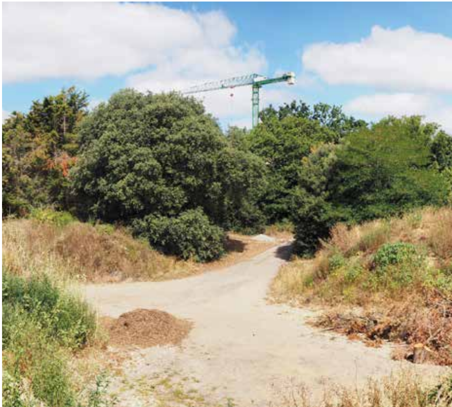
site des anciennes serres municipales © Atelier Ruelle
